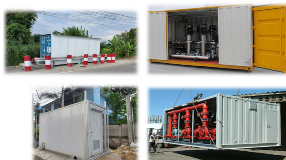
การติดตั้ง Pressure Booster Pump
