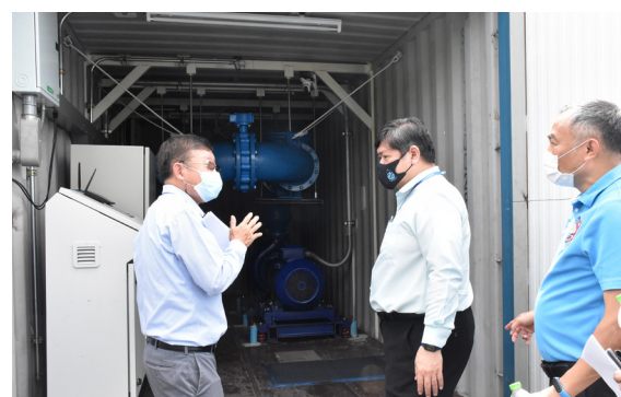
การติดตั้ง Pressure Booster Pump
