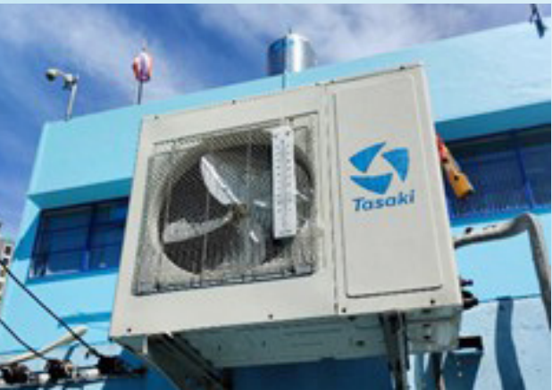
การลดอุณหภูมิคอนเดนเซอร์ด้วยการสปเรย์น้ำ
