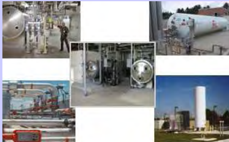
รูปที่ 2 การใช้โอโซนกำจัดเชื้อโรคในระบบผลิตน้ำประปา
