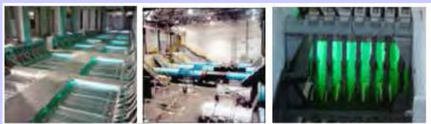
รูปที่ 1 การใช้รังสีอัลตราไวโอเล็ตกำจัดเชื้อโรคในระบบผลิตน้ำประปา
