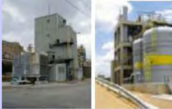
รูปที่ 1 การใช้คลอรีนในระบบประปา
