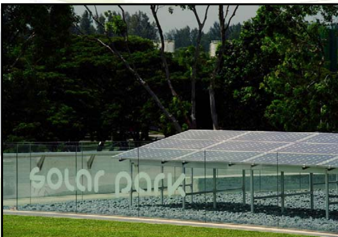
ลานโซลาร์พาร์คติดตั้งแผงโซลาร์เซลล์ สำหรับผลิตไฟฟ้าไว้ใช้ในการควบคุมเขื่อน ปั๊มไฮดรอลิกติดตั้งเครื่องสูบน้ำ 7 ตัวสำหรับสูบน้ำส่วนเกินในเขื่อนระบายออกสู่ทะเล
