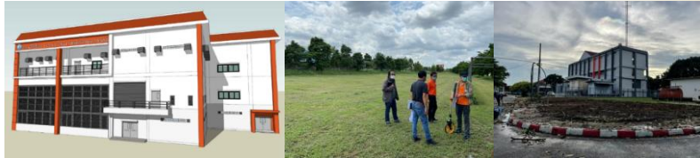
สัญญา S-MS-9 (Sub Station 115/24 kV)
