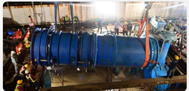
งานสำรวจพร้อมซ่อมบอุมงค์ส่งน้ำ บริเวณถนนประเสริฐมูทิจ และงานตัดบรรองบอุมงค์ส่งน้ำ บริเวณสถานีสูบน้ำมีนบุรี
