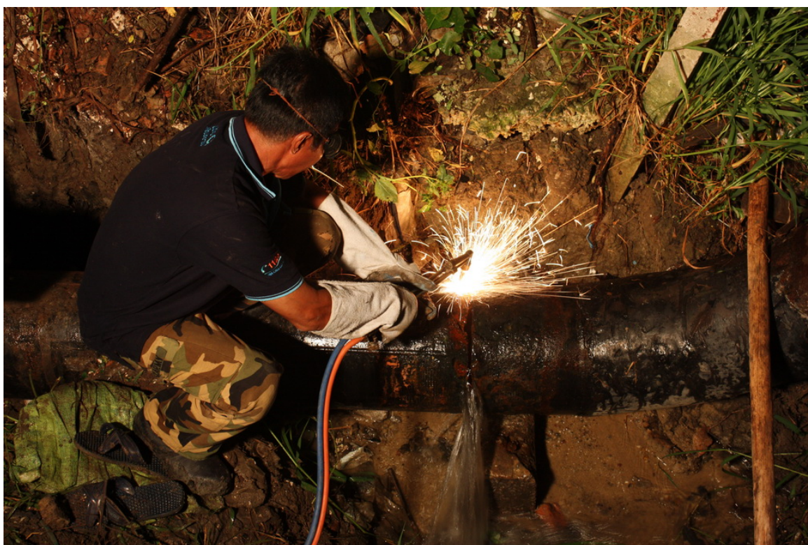
รูป 3-7 ตัดท่อส่วนที่แตกรั่วออกเพื่อบรรจบท่อพีอีทดแทน
