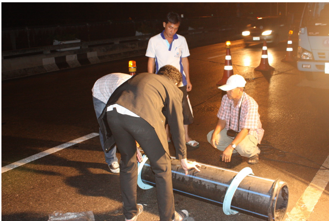
รูป 3-11 ใส่แหวนริมและยาง O-ring เข้ากับท่อพีอีก่อนนำไปประกอบในหลุมงาน
