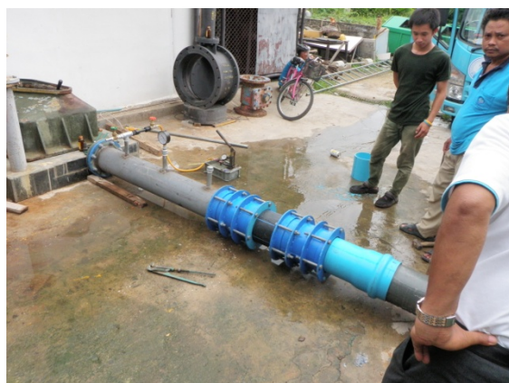
รูป 3-3 สรุปขั้นตอนการปล่อยน้ำเข้าสู่เส้นท่อและทดสอบแรงดันน้ำ 6 บาร์
