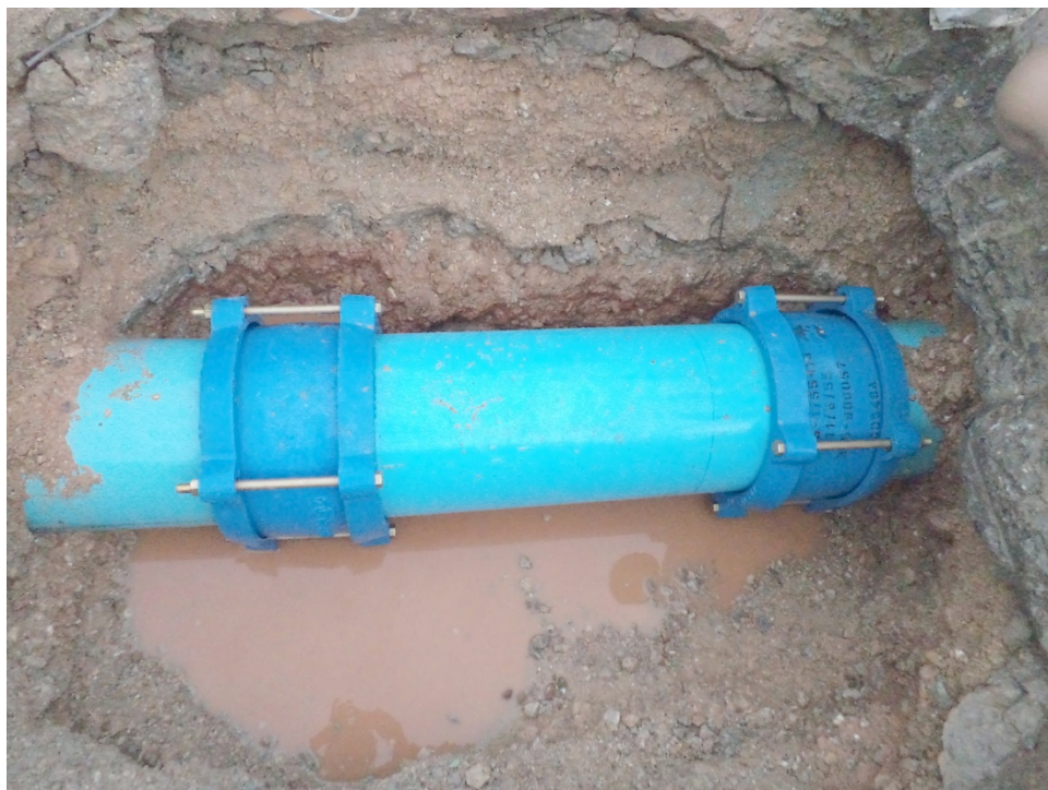
ข) ประกอบท่อใหม่เข้ากับท่อเดิมด้วยข้อต่ออีโบลท์
