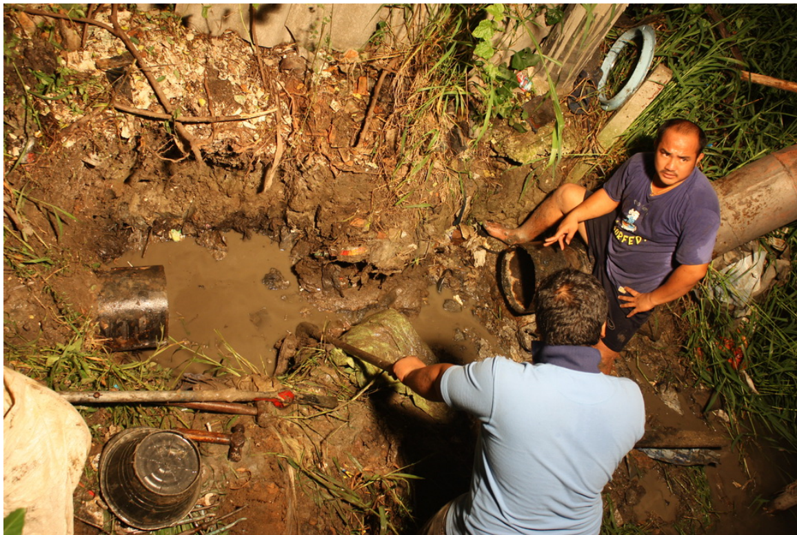
รูป 3-8 เมื่อตัดท่อเสร็จวัดความยาวท่อในส่วนที่จะต้องบรรจุบใหม่
