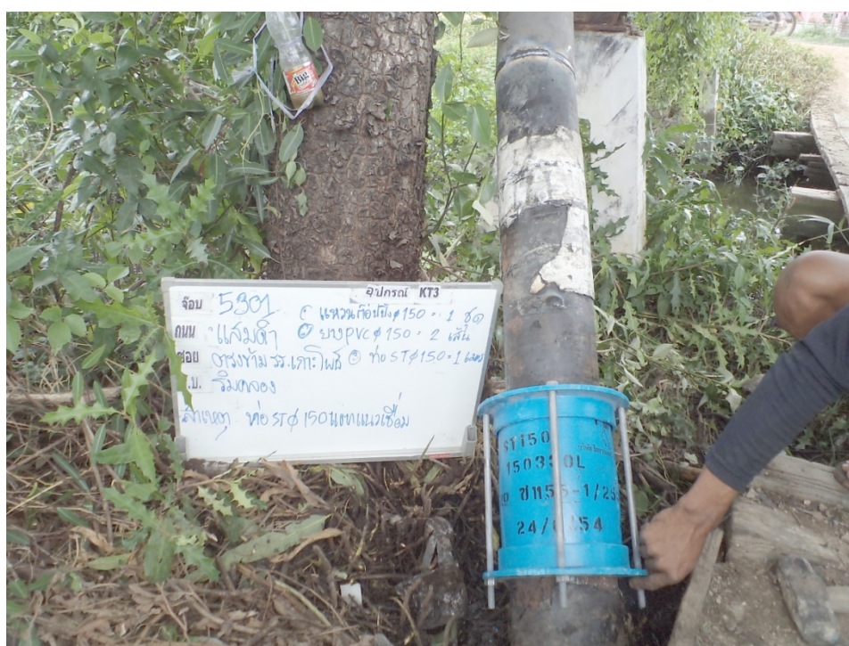
รูป 2-5 Flexible Coupling เชื่อมต่อท่อเหล็กเหนียว
