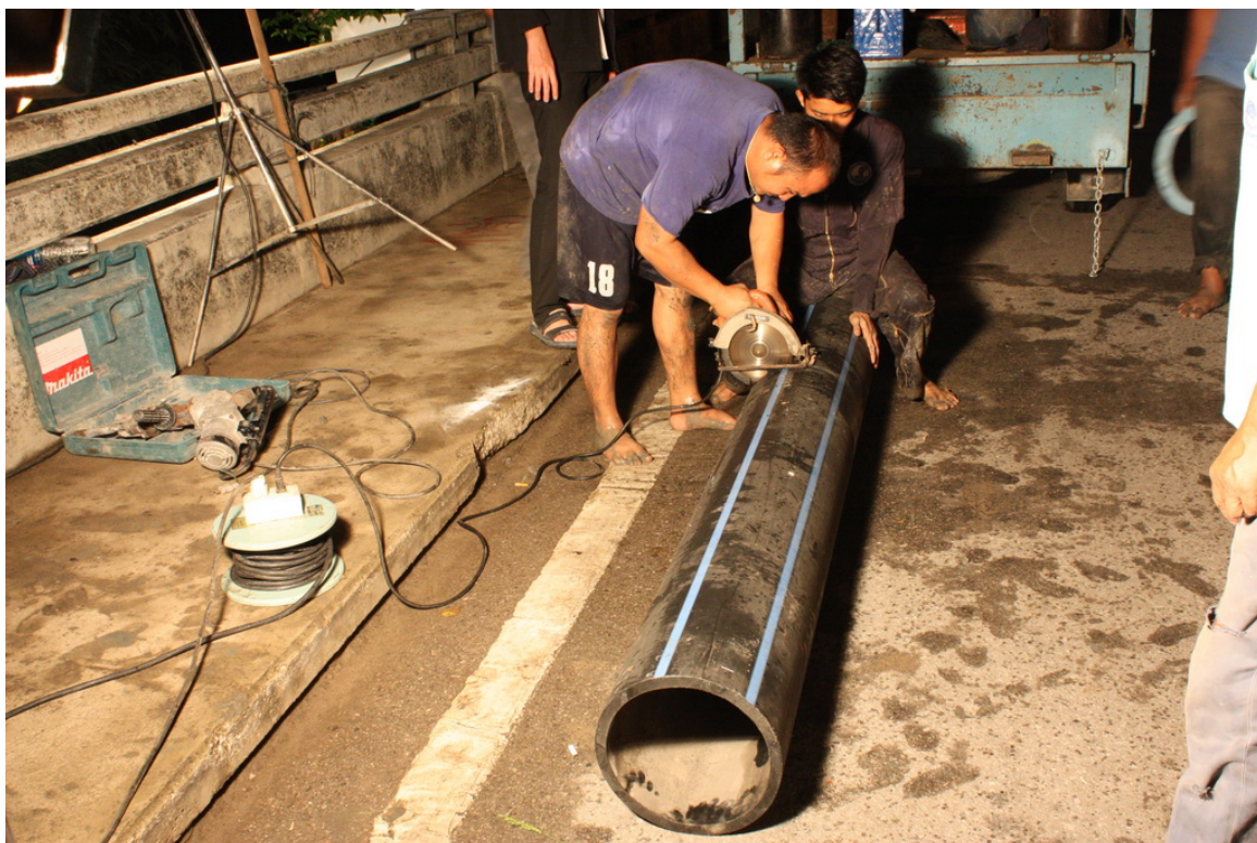
รูป 3-9 ตัดท่อฟีดตามที่วัดได้เพื่อใช้บรรจุบ่อทดแทนส่วนที่ตัดออกไป
