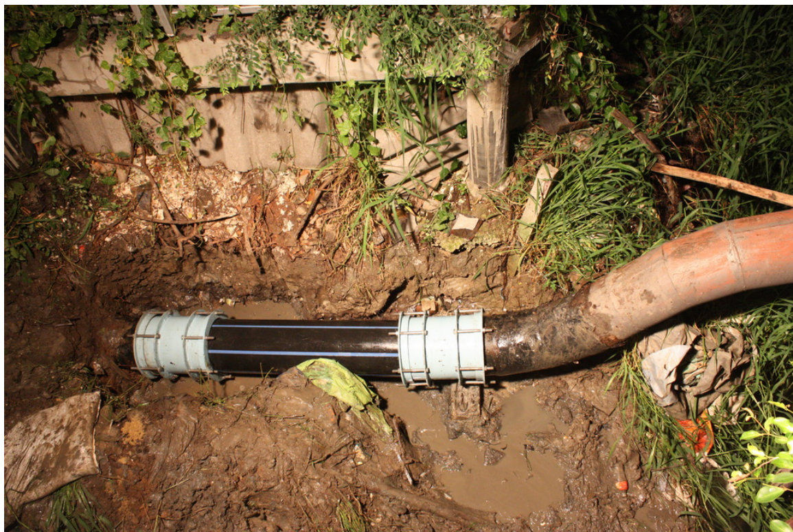
รูป 3-14 เสร็จสิ้นขั้นตอนการเชื่อมต่อโดยใช้แหวนเทวดา
