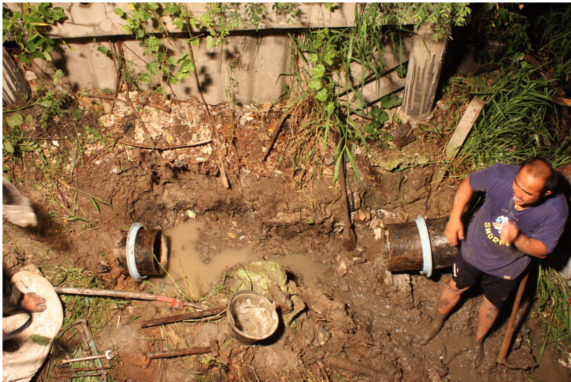
รูป 3-10 ใส่แหวนริมและยาง O-ring เข้ากับท่อเหล็กเหนียว
