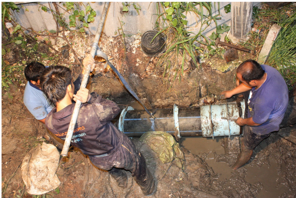
รูป 3-12 บรรจบท่อพีอีกับท่อเหล็กเหนียวโดยใช้แหวนเทวดา
