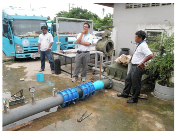
รูป 3-3 สรุปขั้นตอนการปล่อยน้ำเข้าสู่เส้นท่อและทดสอบแรงดันน้ำ 6 บาร์
