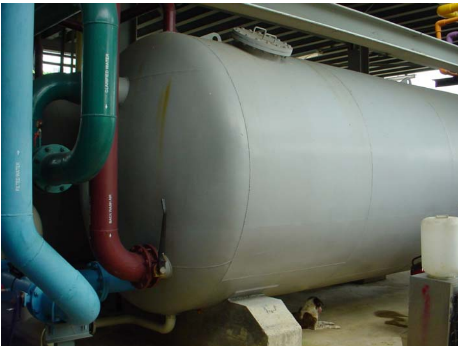
ภาพที่ 7 ถังกรองน้ำแบบปิดทรงกระบอกแนวนอน (Horizontal sand filter) นิยมใช้กับการกรองประเภท Pressure Sand Filter. แต่สามารถประยุกต์ใช้กับการกรองประเภท Rapid Sand Filter ได้
