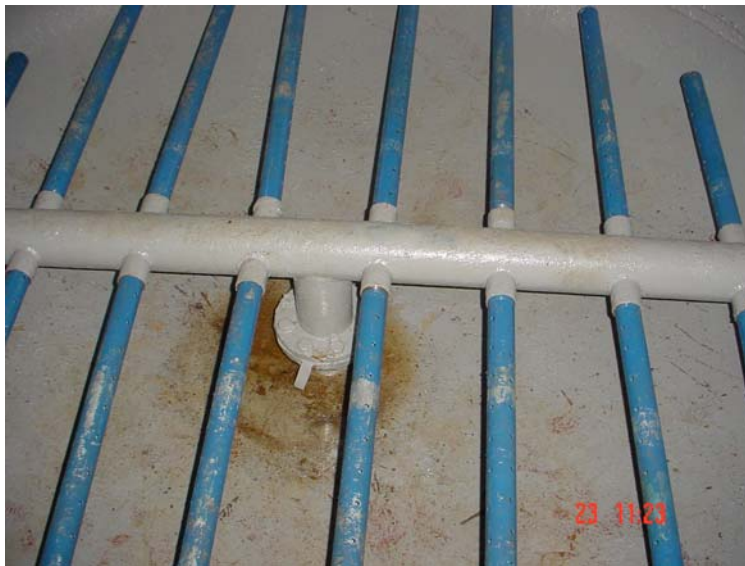
ภาพที่ 3 แสดงการวางหัวกรองน้ำแบบท่อแกงปลาหรือแบบแขน(Arm)
