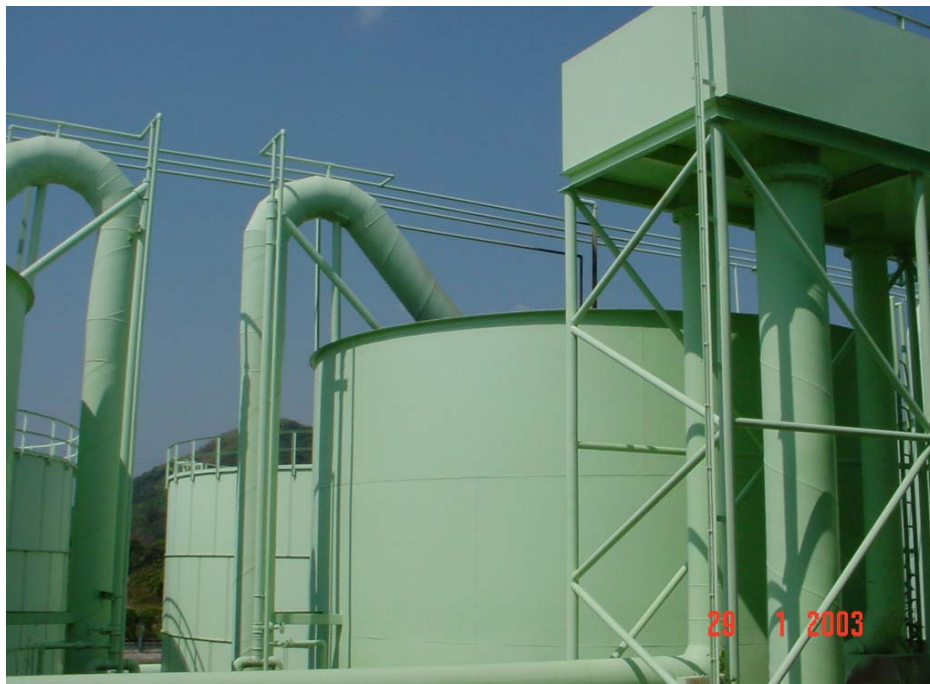
ภาพที่ 8 ถังกรองน้ำแบบล้างกลับอัตโนมัติ (Self Back Washing)
