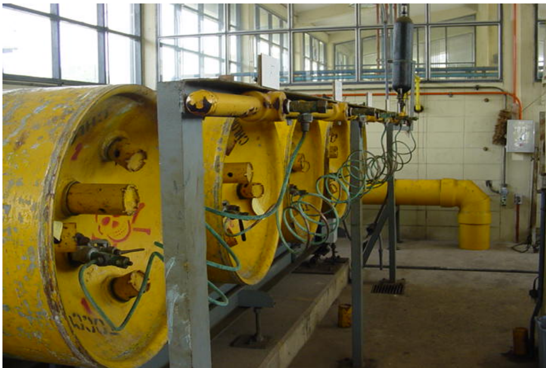
รูปที่ 4 ภาพขณะบรรจุคลอรีนขนาด 1 ตัน
