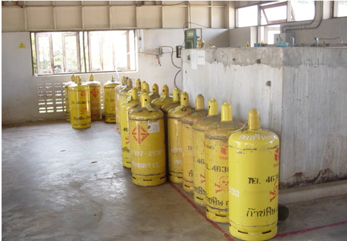
รูปที่ 3 ภาพขณะบรรจุก๊าซคลอรีนขนาด 100 กก.
