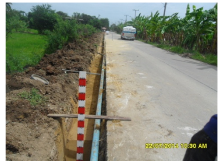
การวางท่อประปา ของการประปาครหลวง
